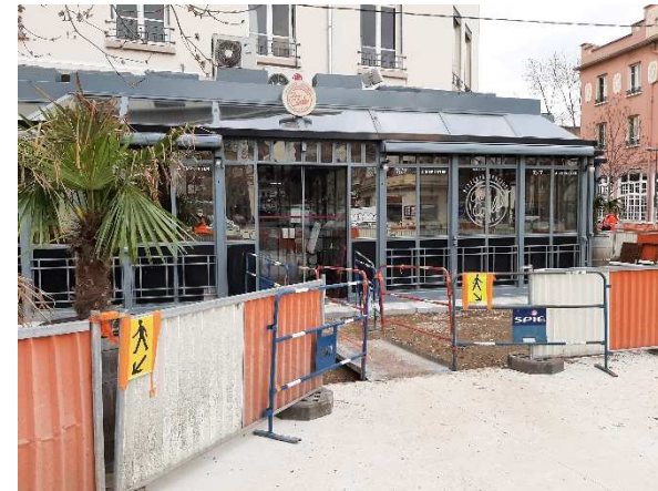
Barrière chantier et dispositif accessibilité
